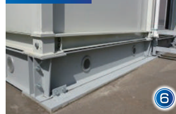
H鋼基礎(レンタル)
