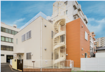
保育園(2階建+屋上)外観
