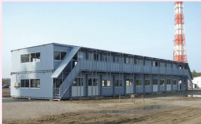
FLEX-H40／現場事務所
