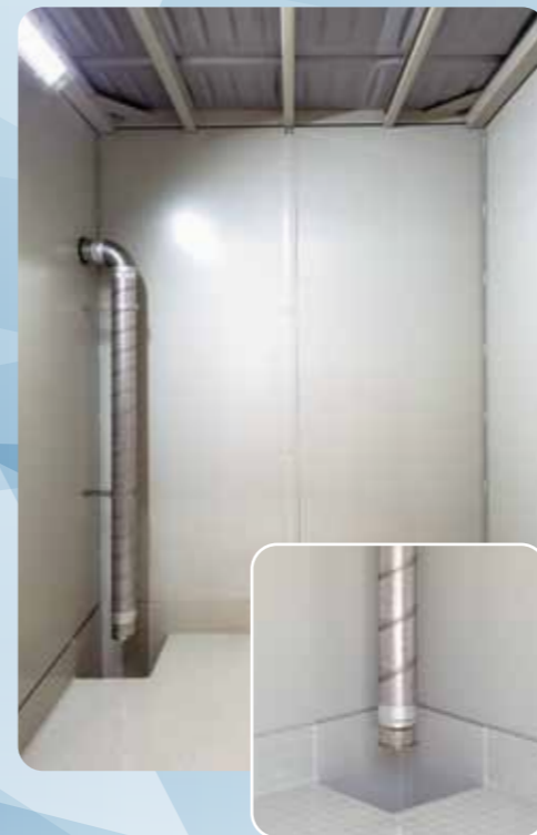
溜め升・防油堤(室内)
