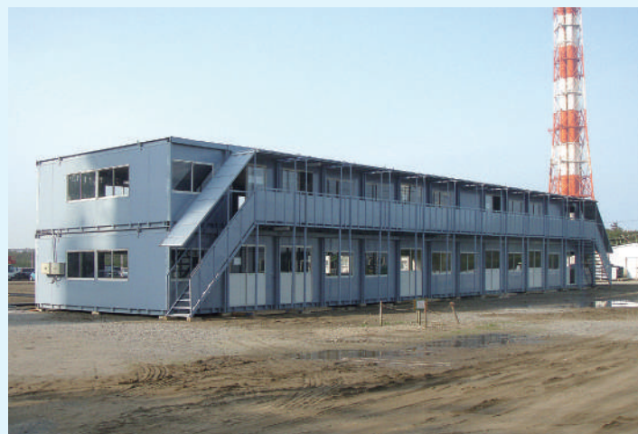
FLEX-H40／現場事務所
